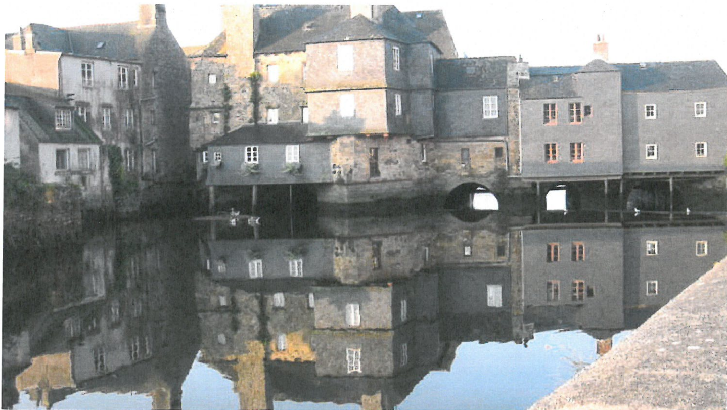
Landerneau, hier die berühmte bebaute Brücke, ist die Partnerstadt von Hünfeld. © Stadt
